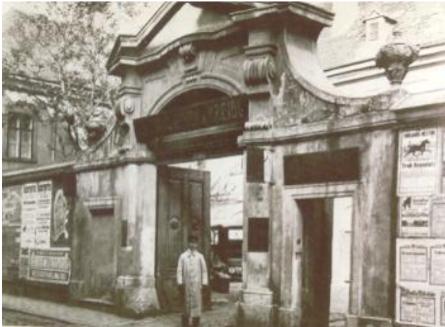
Eingang zum PALAIS MESMER, Landstraße 261 (heute Rasumofskygasse 29) vor der Demolierung im Jahre 1920
